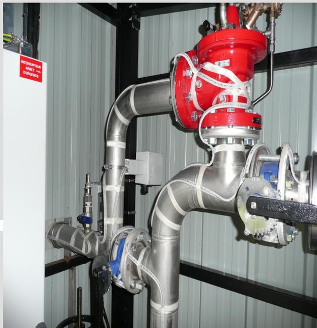
Traçage électrique de tuyauteries et d'accessoires
